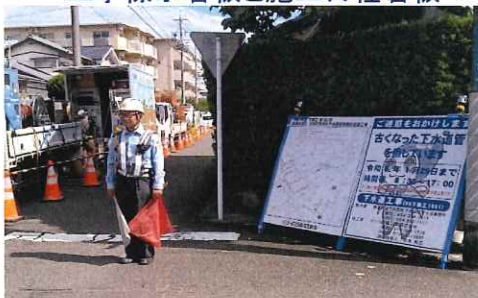
工事標示看板と施工日程看板
