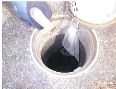
消臭剤の設置(汚水樹)
