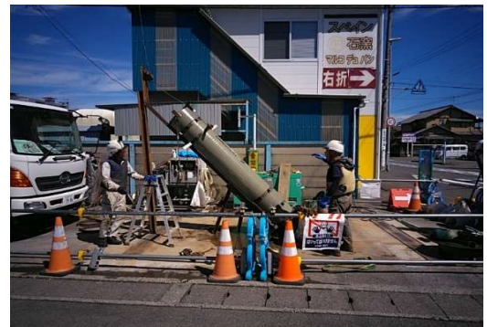
\phi 400\text{mm} FRPM管挿入
