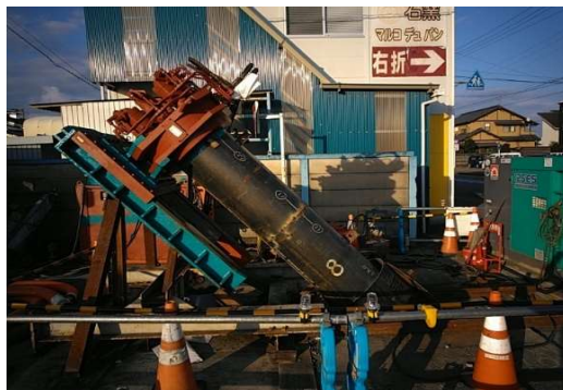
\phi 550\text{mm} 鋼管削進
