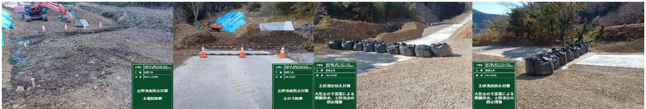
図-4 施工中の土堤防・土のう設置による土砂流出防止（左側2枚）
