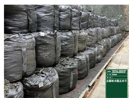
ただ、狭隘な箇所であることに変わりはない。(掘削計画正面図、掘削計画断面図参照)1,300<sup>m</sup>の掘削を始めることとした。右岸法面(地上部)からの落石防止対策として、作業通路山側に大型土のうによる仮土留め設置、法面に落石防止ネットの設置を行い作業通路の安全確保を整備した。作業するバックホウは全てクレーン仕様機種を使用した。掘削は1次掘削として、奥のほうから0.7<sup>m</sup>級バックホウで深さ3.0mを目安に掘削、排土を行った。掘削は本堤～副堤間の全体に及ぶため、側壁部の掘削終盤に0.4<sup>m</sup>級バックホウを掘削箇所に投入した。
