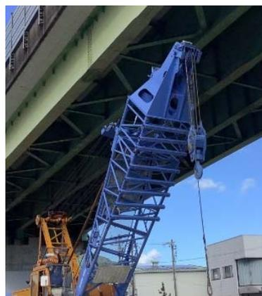
比較検討した結果、低空頭スライド式工法では、ケーシングや鉄筋籠の数が多くなり、もともと狭い施工ヤード内に仮置き等をするスペースが確保できないことやケーシングや継手の数の増加に伴う施工性の低下や特殊機械で費用の増加が必要なため、上空制限の監視方法さえ確保すれば施工は問題なく施工できる低空頭クレーンによる施工を行うこととした。
