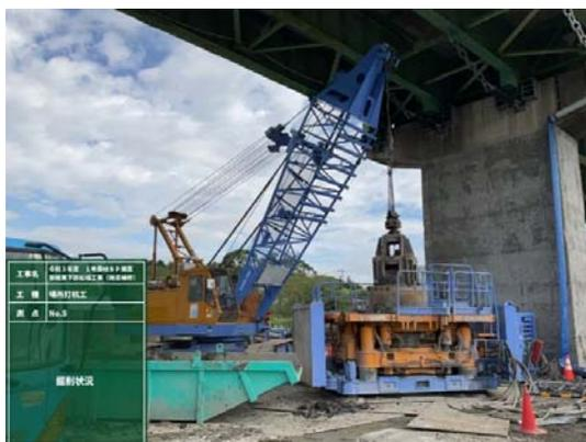
低空頭クレーンによる掘削状況
