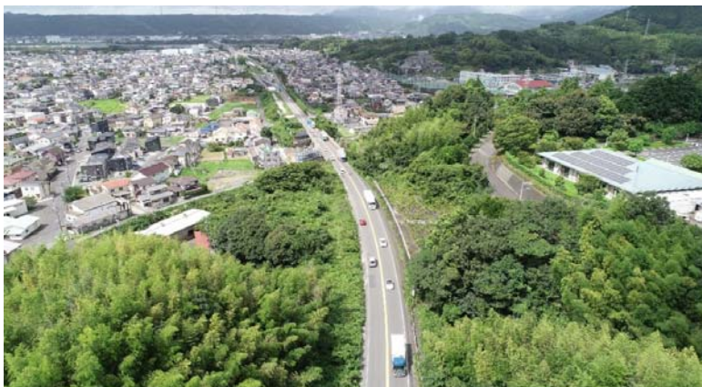
野田地区 施工前現況写真
