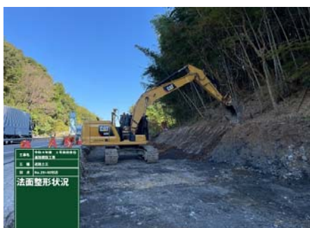
野田地区 ICT道路土工 掘削状況
