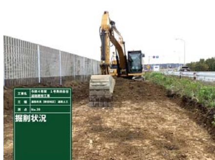
野田地区 ICT道路土工 掘削状況
