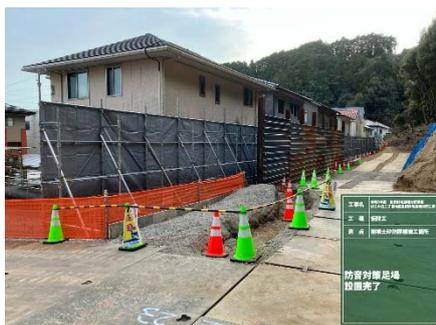
削孔時スライム飛散防止
