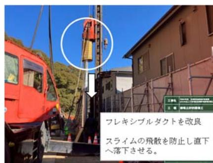
大口径ボーリングベースマシン（35t 吊ラフテレーンクレーン）の走路については、施工ヤード整地後にトラフィカビリティーを確認する為、コーン指数をコーンペネトロメータで計測した。目標値をダンプトラックが走行できる  $1,200\text{kN/m}^2$  以上としたが、測定換算値は  $830\text{kN/m}^2$  であり不足していた。砕石敷で補う事も検討したが、ラフテレーンクレーンはダンプトラックに比べ輪数が少なく（6輪→4輪）タイヤに掛る接地圧がより大きい事、地盤は細粒分が多い水はけの悪い地盤の為、降雨になると急激に含水比が高まりコーン指数が更に低下する事を考慮し、より確実な敷鉄板を設置してこれを補う選択とした。
