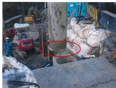
写真-3 拡径ビット使用状況
