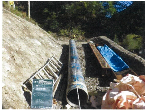
写真-4 ケーシングパイプ(保護管)
