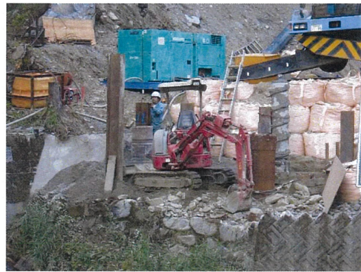
写真-6 H鋼建込み状況
