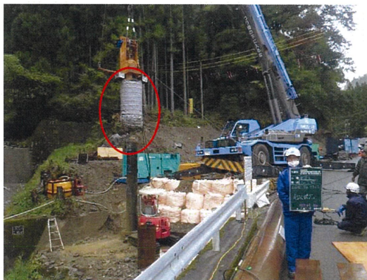
写真-5 掘削状況
