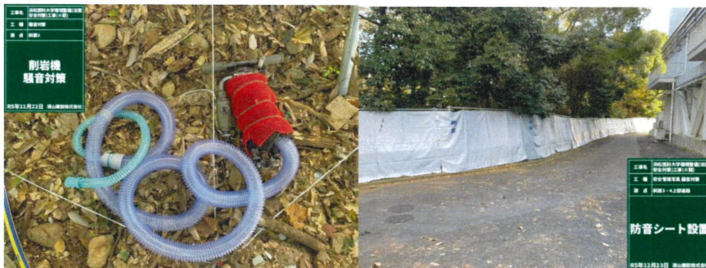
削岩機への防音対策と防音シートの設置
