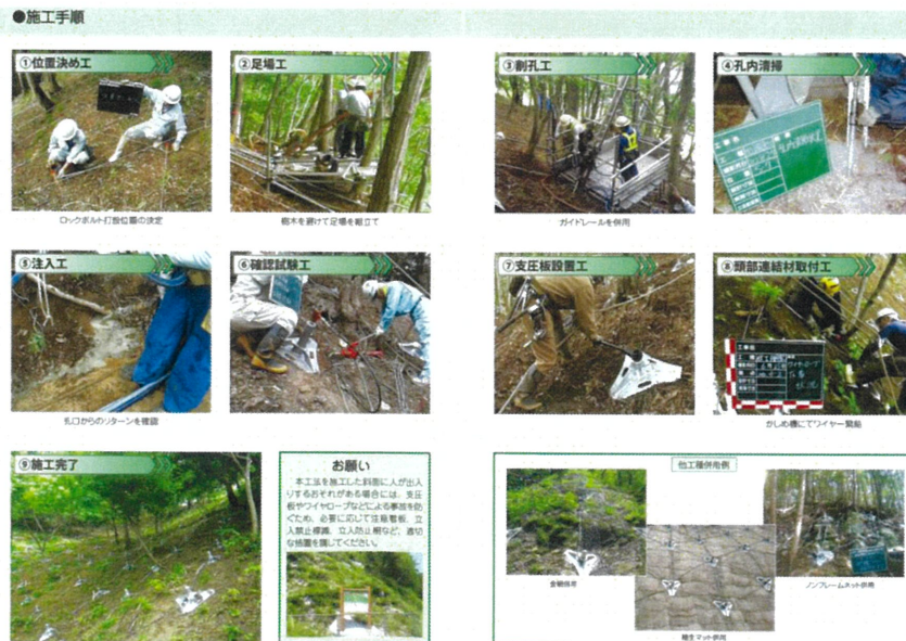
ノンフレーム工法施工手順
