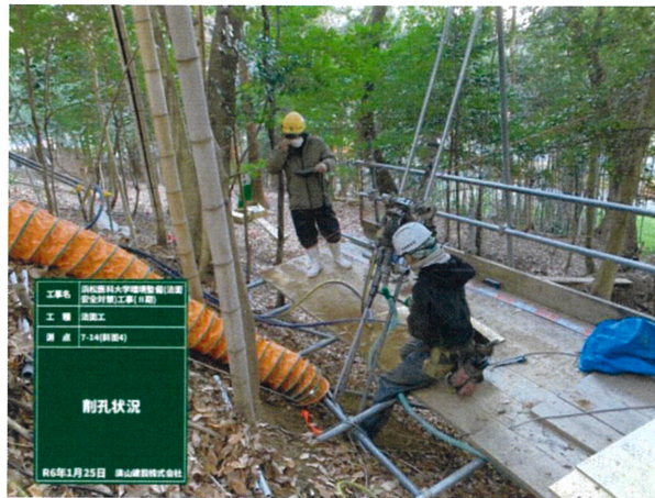
削岩機による削孔状況
