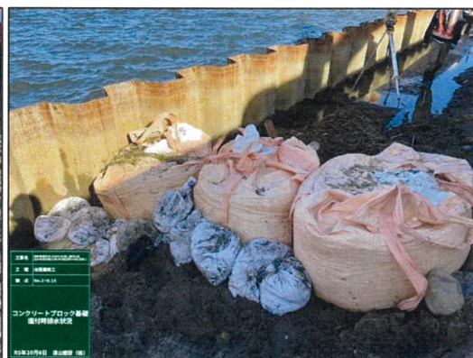
写真-5 大型土のうによる仮締切
