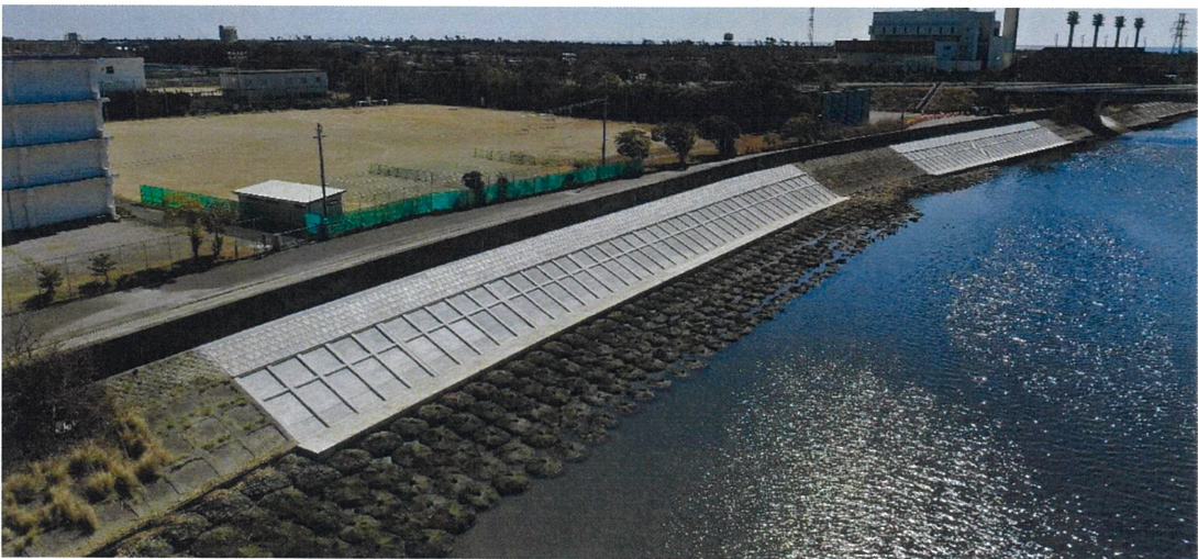
写真-7 完成写真（上流から下流を望む）
