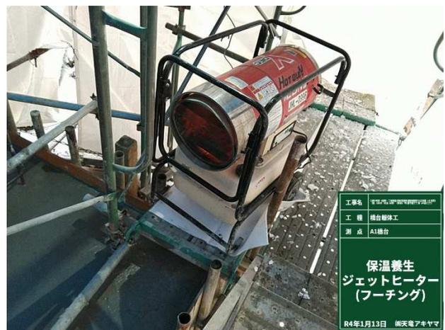
【前回工事 A1 橋台養生状況】 足場全体をシートで覆い内部をジェットヒーター2 台にて加温
