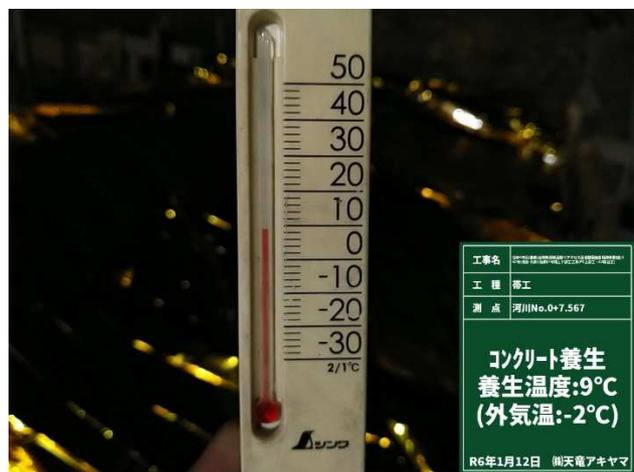
外気温-2°Cに対して養生温度9°Cを確保
