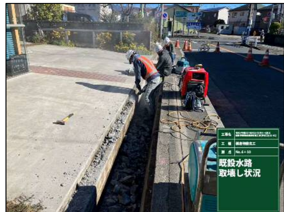
【人力による取壊し(定休日)】
