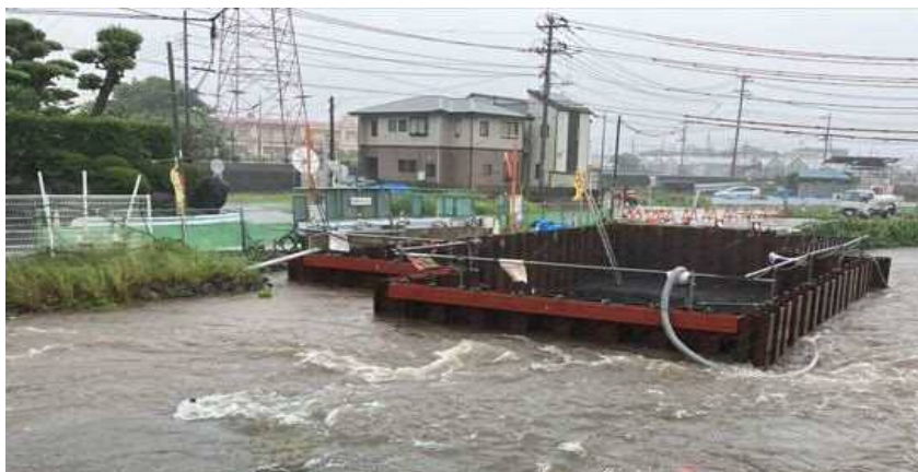
上流から下流を見る (R5. 6月の増水状況)
