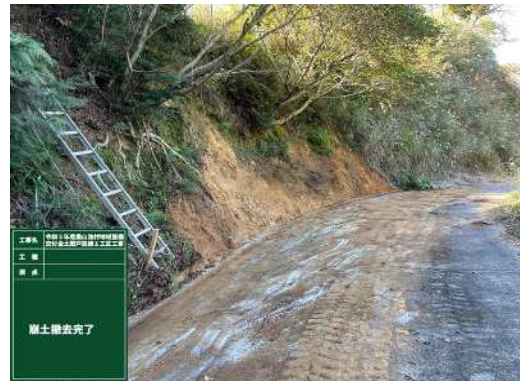
【 施工箇所② 】
