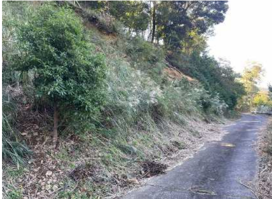
【 施工箇所① 】
