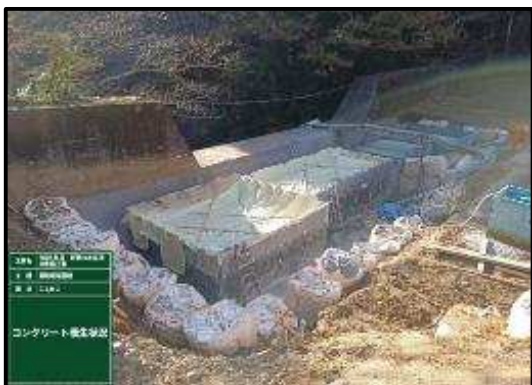
【鋼製堰堤基礎工施工中の水替え状況】
