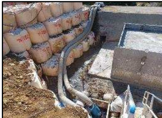
【鋼製堰堤基礎工施工中の水替え状況】
