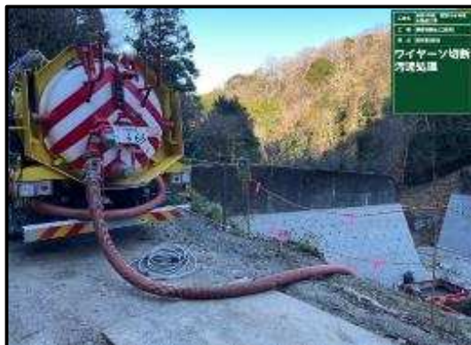
【バキュームによる汚泥搬出処理】
