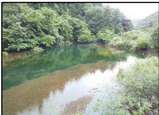
【堰堤上流側の滞水状況】
