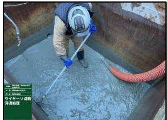
【バキュームによる汚泥搬出処理】
