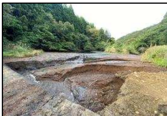
【堰堤上流側のばっき乾燥状況】
