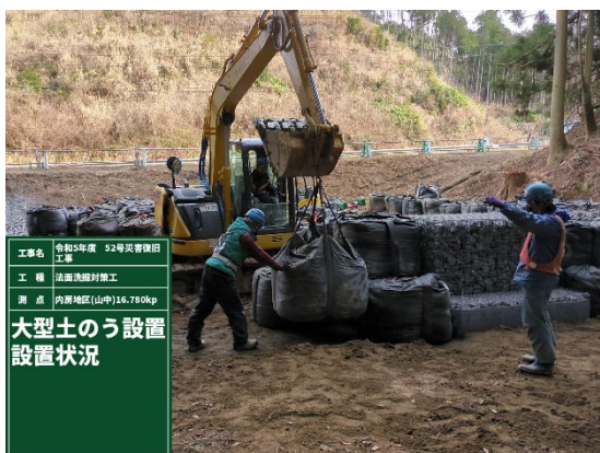
写真-7. 大型土のう設置状況
