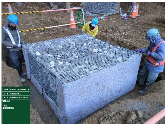
写真-5. 鋼製かご設置状況
