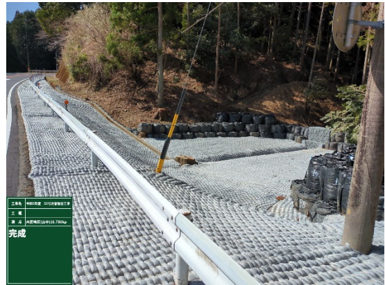
写真-10. 布製型枠施工完了
