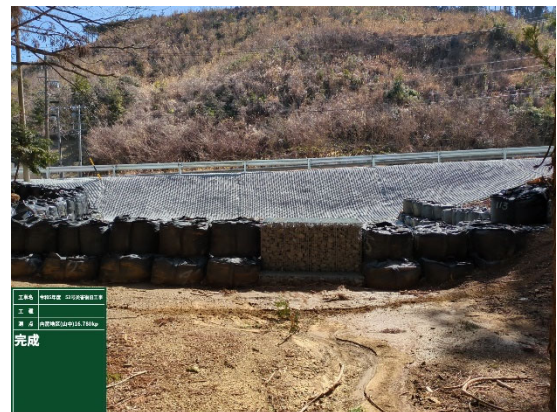
写真-6. 鋼製かご設置完了
