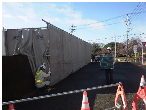
防音シート張り（北面商業施設側）
