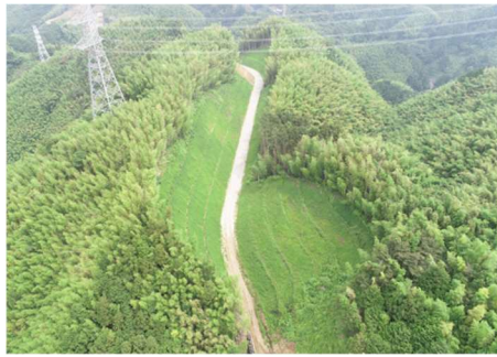
植生基材吹付
