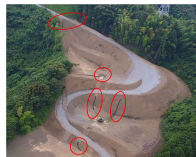
集水場、暗渠管設置
