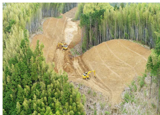
ICT掘削状況(丁張不要)
