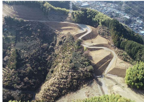
盛土施工完了
