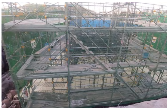
フーチング部養生状況
