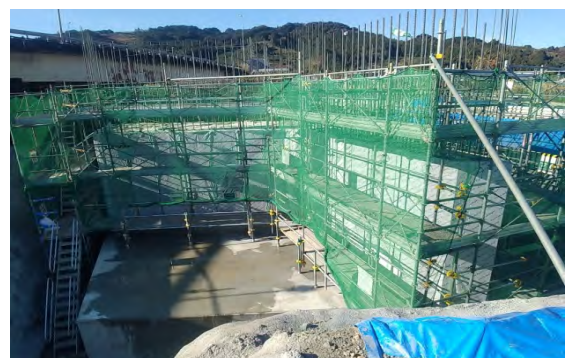
躯体部養生状況
