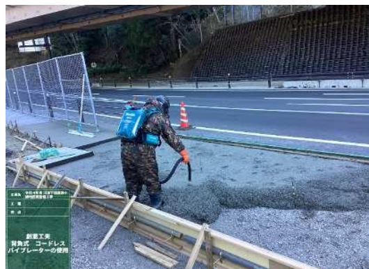
コードレス高周波バイブレーター使用状況
