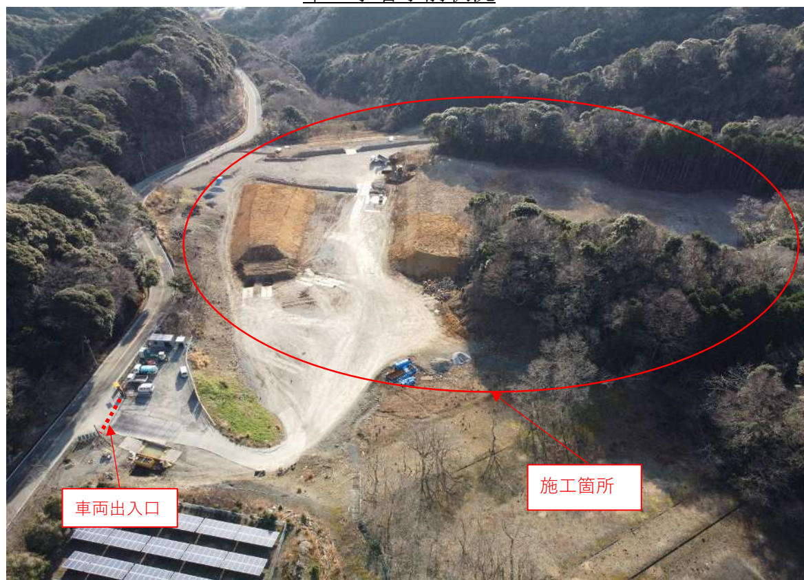
本工事着手前状況
