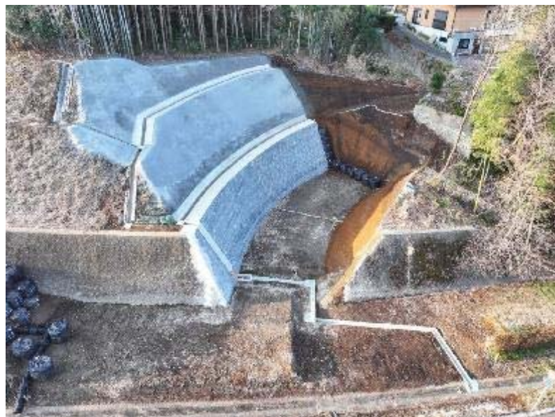
上空より施工箇所全体を望む
