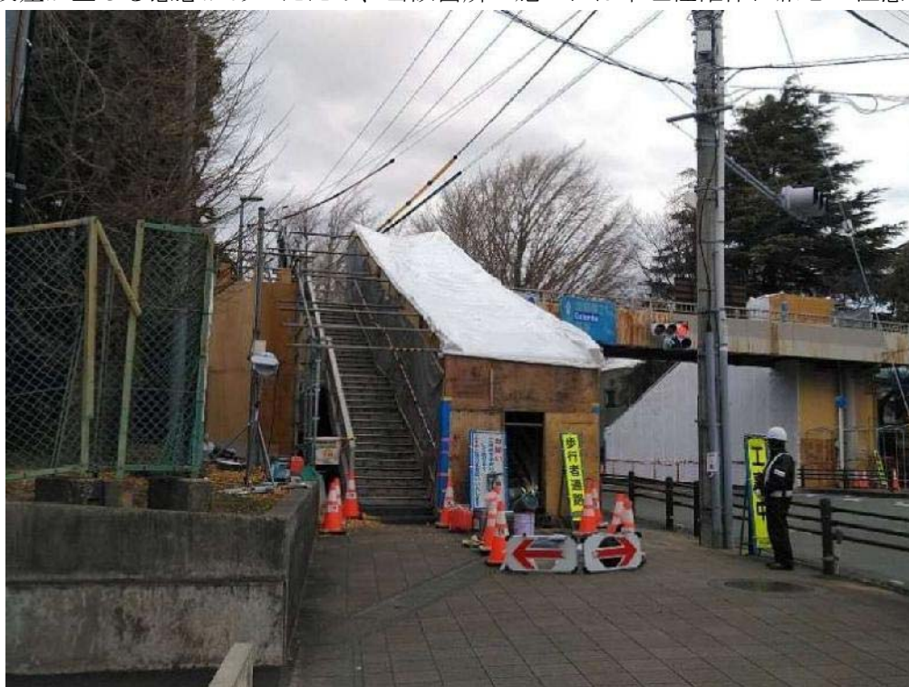
階段部の 2 分割施工状況
