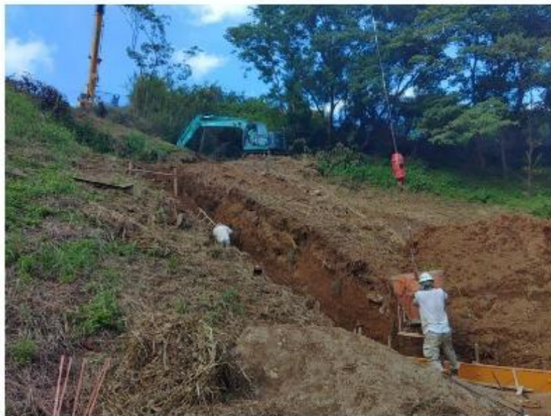
50t ラフテレーンクレーンによるコンクリート打設
