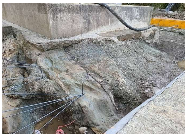
写真-3 床付け面（岩盤露出）
