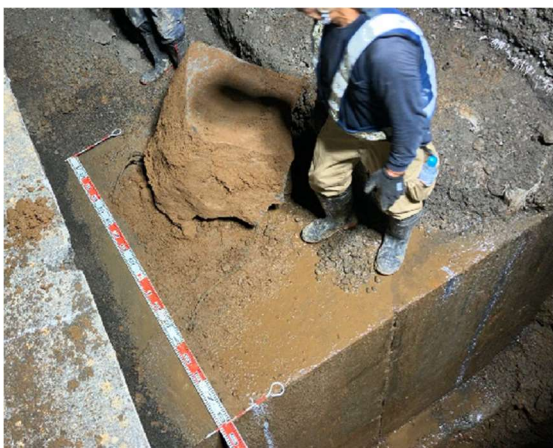
既設ボックスカルバート
