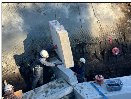
写真-4 プレキャスト小口止め施工状況
