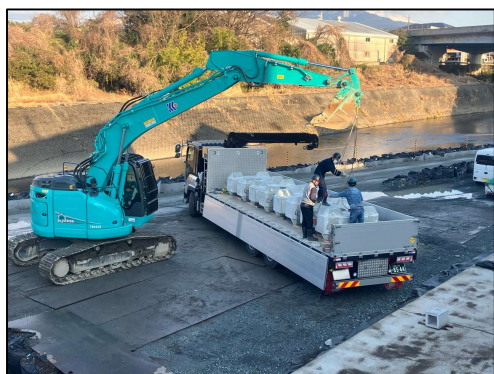
写真-8 根固めブロック荷卸し状況
