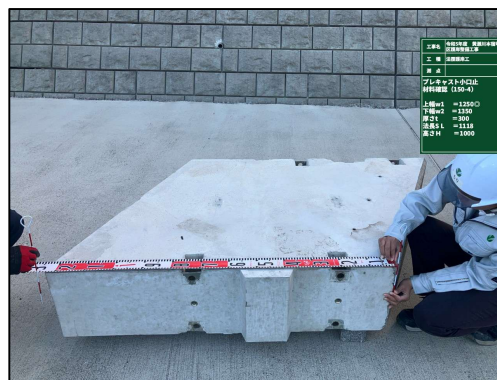
写真-5 プレキャスト小口止め材料確認
