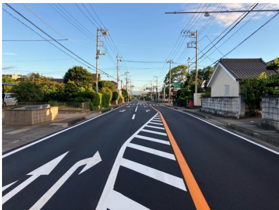
工事完成写真
