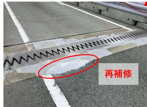
図-5-2 再補修状況
