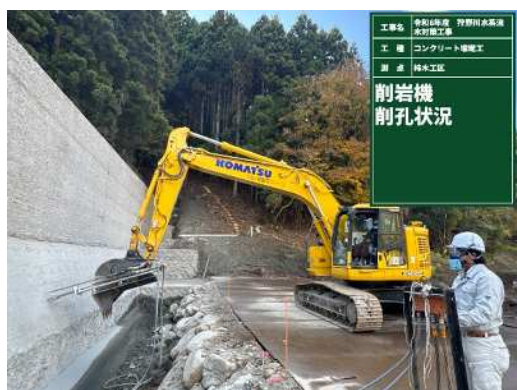
アタッチドリルによる施工状況
