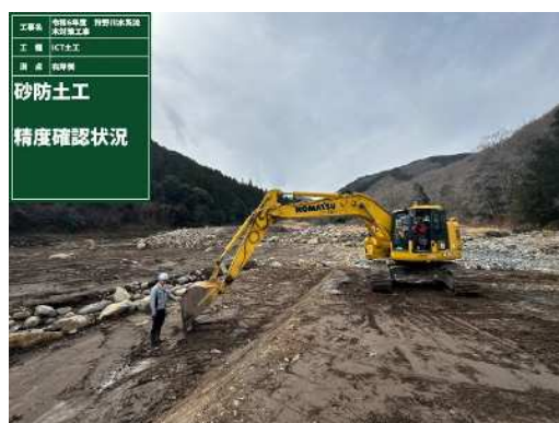
ICT 建機による施工状況
