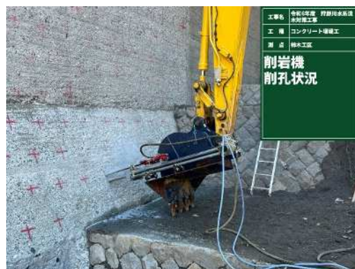
アタッチドリルによる施工状況
