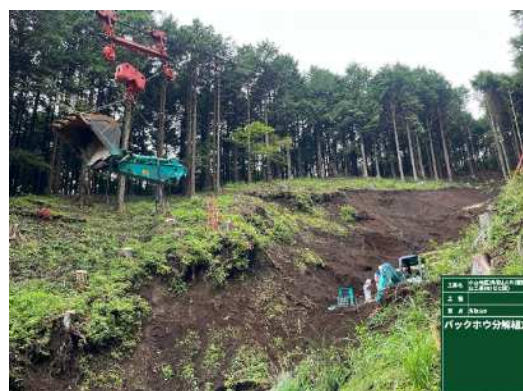
写真-6 重機の搬入状況
