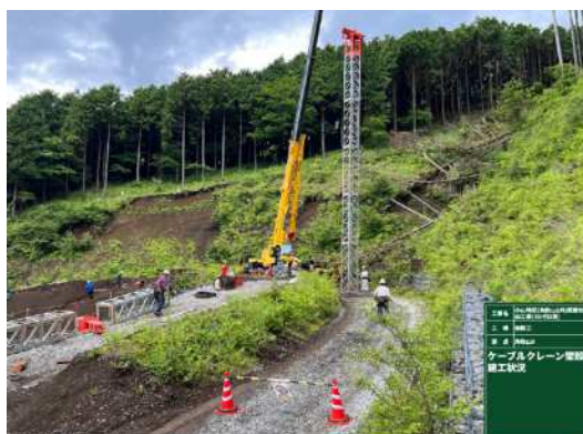
写真-5 ケーブルクレーン架設状況
