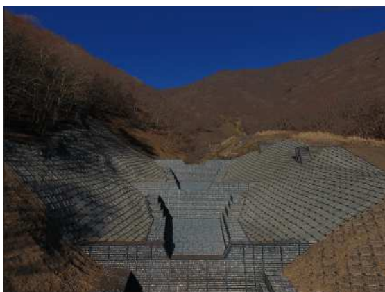
写真-1 角取山 1 完成写真
