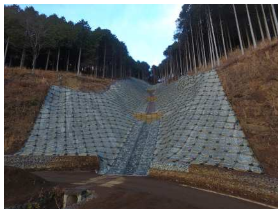
写真-2 角取山 9 完成写真
