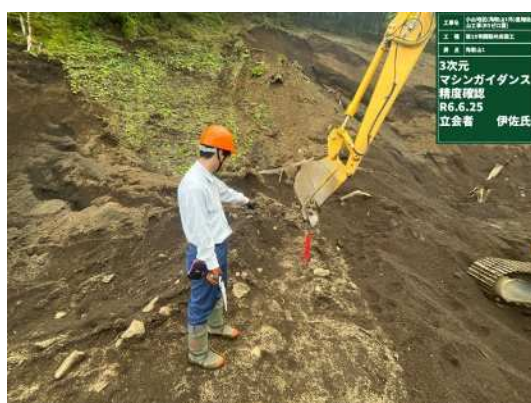
写真-3 マシンガイダンス 精度確認
