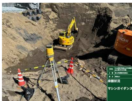
写真-4 ICT 建機による施工状況
