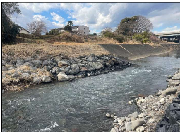
本宿工区：護岸補修 完成全景
