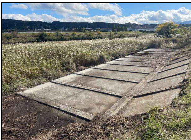
神島工区：護岸補修 完成全景
