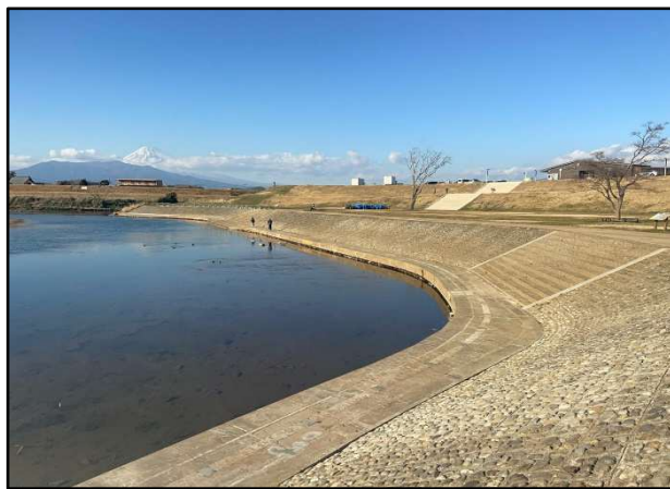
川の駅：河川維持 完成全景
