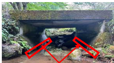
充填工法及び洗堀箇所
