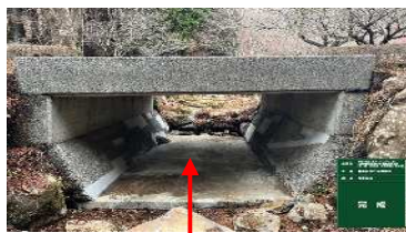
底版及び洗堀箇所生コン打設
