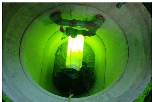
古い管の内側に、新しいシートをはり付け、紫外線により硬化させる
