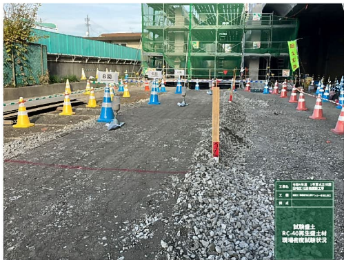
【試験盛土 現場密度試験】
