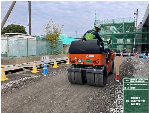
【試験盛土 転圧状況】
