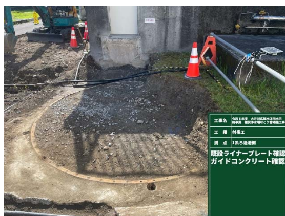
1 系ろ過池北側（H24 施工確認）
