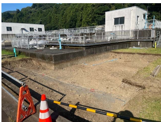
2 系ろ過池北側（試掘完了）
