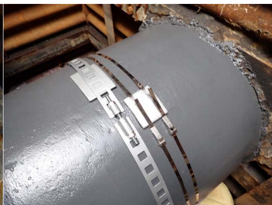
補修バンド設置
