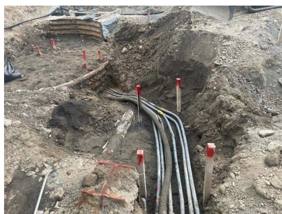
1 系ろ過池北側(試掘状況)
