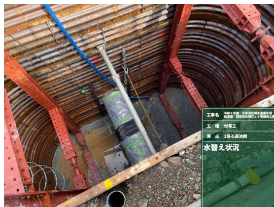
2 系ろ過池北側
