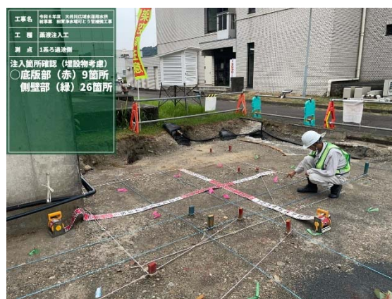
1 系ろ過池北側(注人工前)
