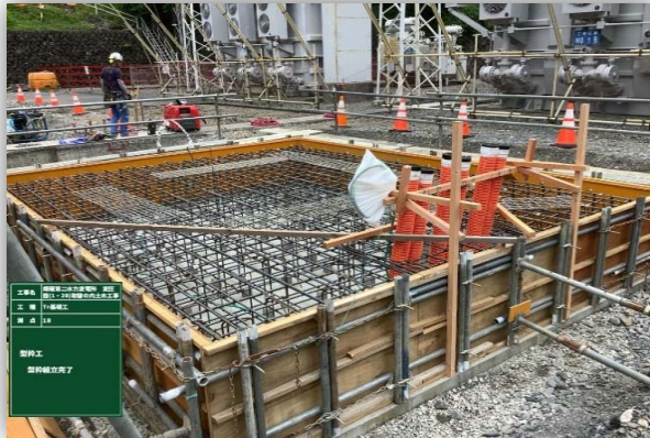
一次コン 型枠完了
