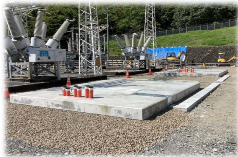
二次コンクリート 完了
