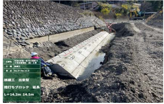
陸打ちブロック据付完了
