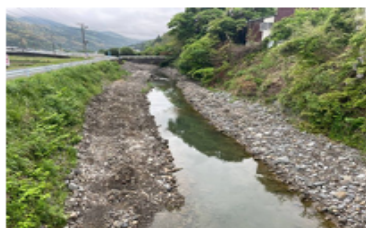
創意工夫：仮排水路掘削状況（施工箇所より250m下流より）
