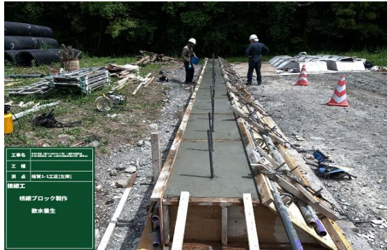
陸打ちブロック製作状況
