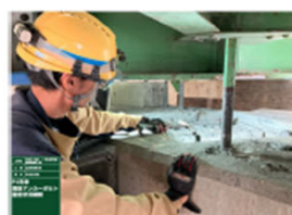
固定状況確認
