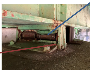
取替える支承
