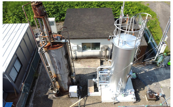
本工事で手前の状況
