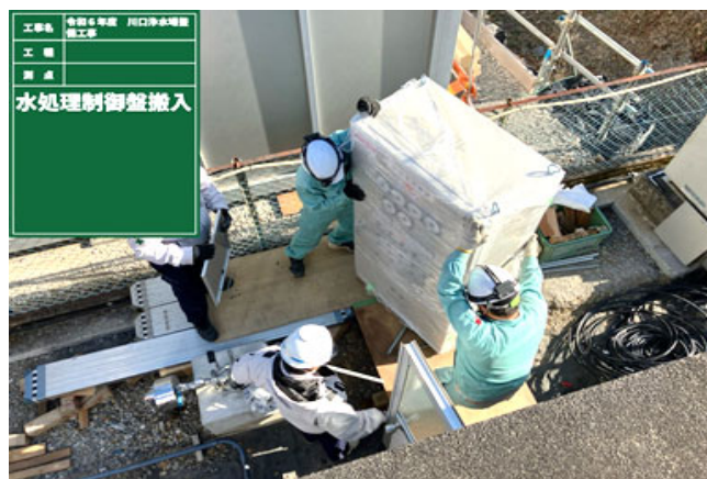
水処理制御盤搬入状況
