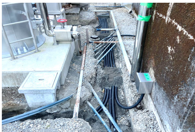
電線管路の敷設状況
