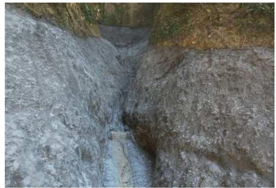
施工完了(特殊モルタル吹付け完了)
