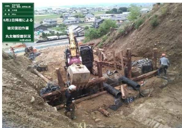
横丸太をザウルスロボで設置
