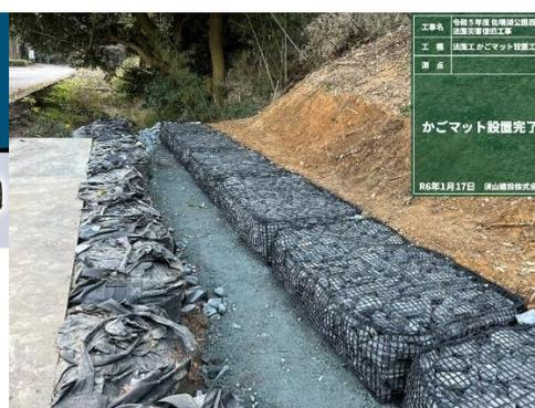
写真-5 FIT-CUBE 設置状況
