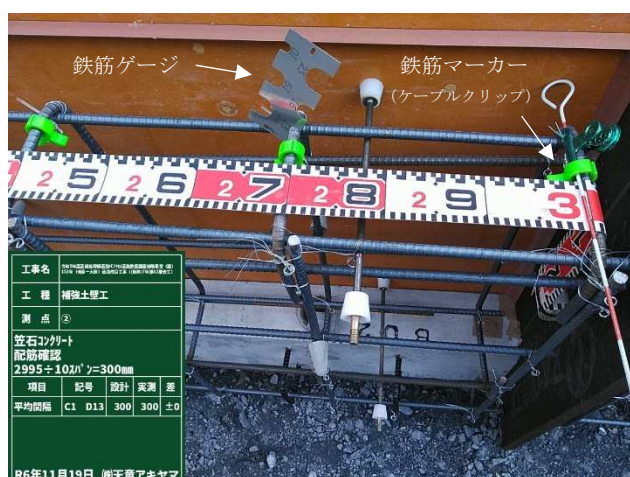
笠石コンクリート 配筋確認
