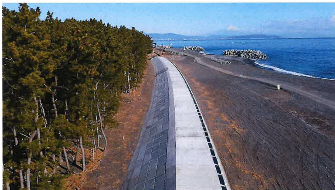
工事完了全景
